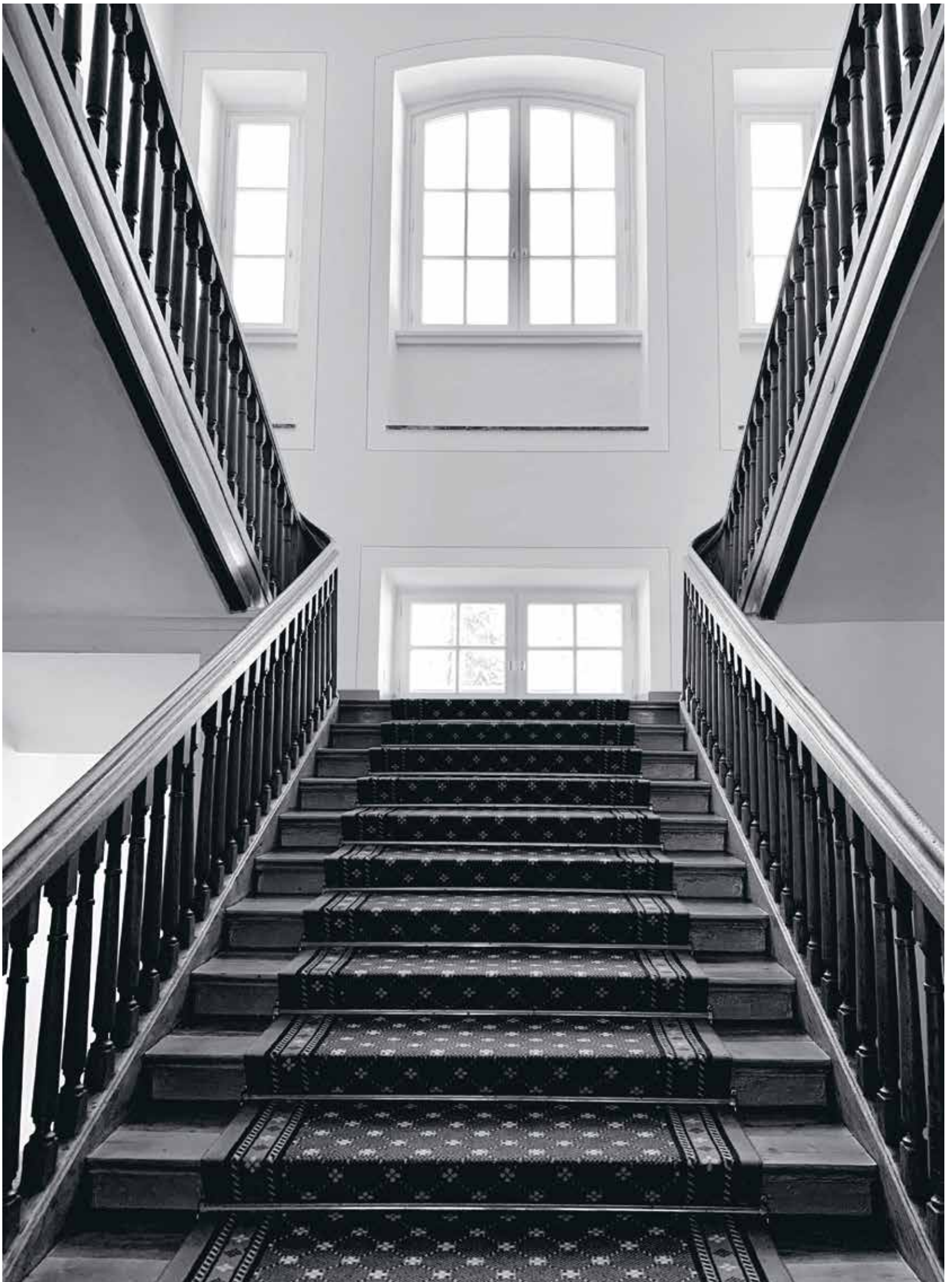
NOBLESSE OBLIGE Architektonische Details wie dieser Treppenlauf aus dem 19. Jahrhundert erinnern an die aristokratischen Ursprünge des Königlichen Kurbads. Besucher der aktuellen Pop-up-Lodge können es in unverändertem Zustand erleben.
